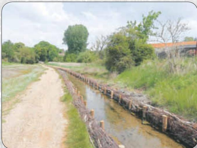
Fertiggestellter Teilabschnitt des Solgrabens mit neuer Uferbefestigung
